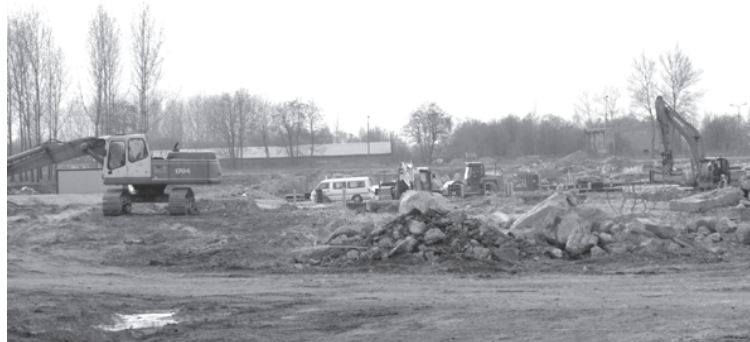
Nawet podczas uroczystości wmurowania kamienia węgielnego pod jej budowę, koparki nie miały wytchnienia – praca wrzała.
