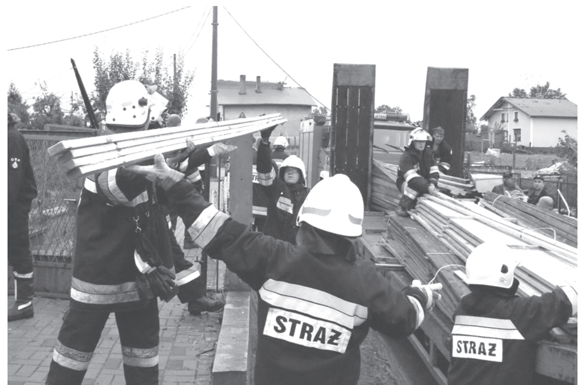
Strażacy z OSP rozładują materiały do remontu dachów
