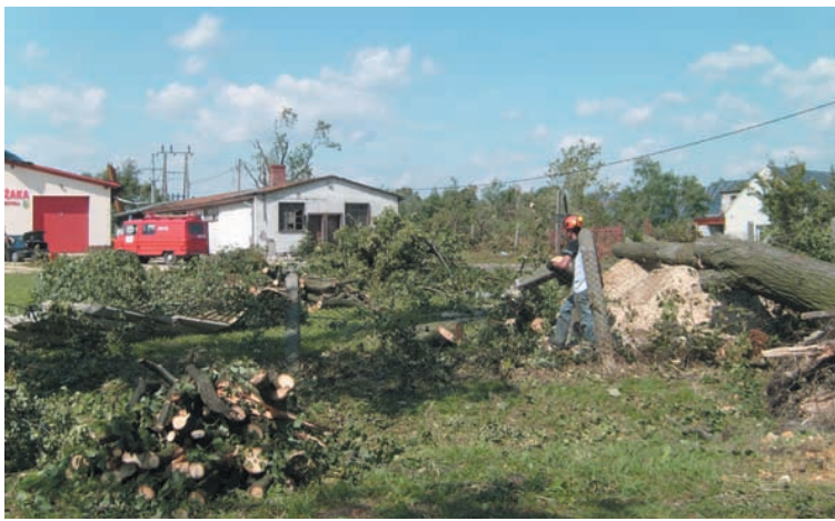
Blotnica Strzelecka, 18 sierpnia, dach OSP uszkodzony, przed budynkiem powalone drzewa
