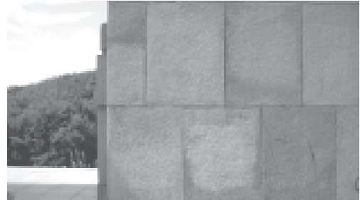
Napisy usunięte zostały metodami chemicznymi przy pomocy rozpuszczalników i ich mieszanin przez firmę konserwatorską. Prace zakończono 30 lipca 2005r.
