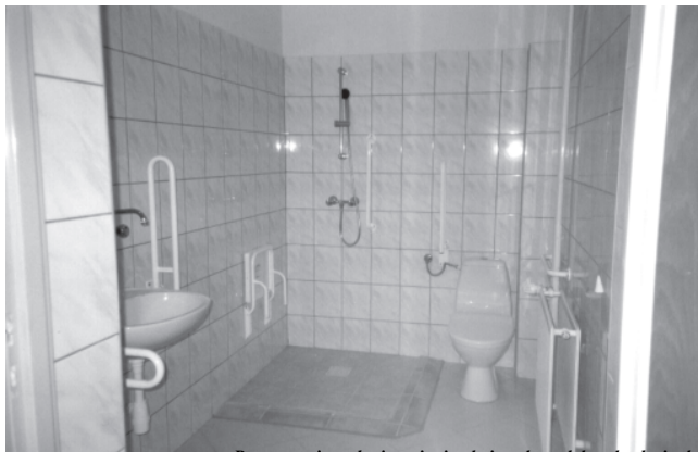
Po remoncie podopieczni mieszkają w kompleksach z łazienką i toaletą przystosowaną dla osób niepełnosprawnych
